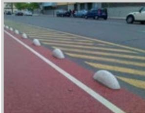
**Material:** Hormigón armado con acero B500S e hidrofugado en masa. De peso 29 Kg, delimitador carriles bicis
