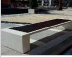
**UHPC (HORMIGON DE ALTAS PRESTACIONES) ARMADO CON ACERO B500S E HIDROFUGADO EN MASA**
